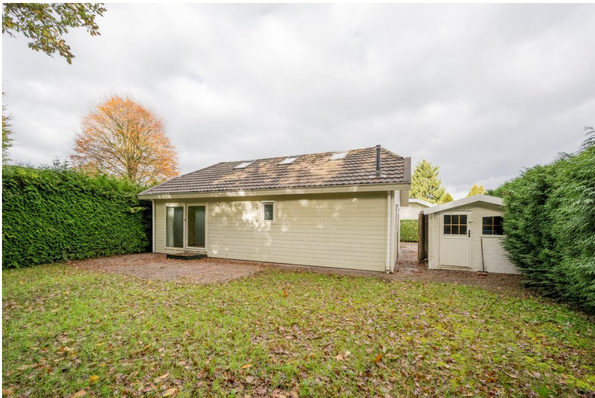
Links de schuifpui in de woonkamer. Rechts de houten berging.
